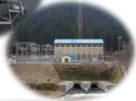
揖斐川町広瀬発電所▶
